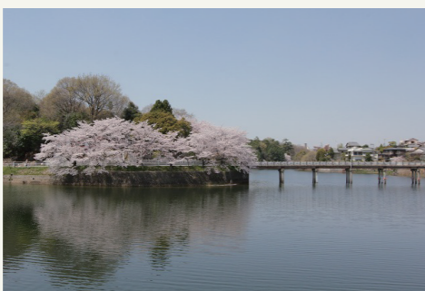
蛙股池に架かる綾女新橋。通学路でもあり生活道でもあるが、老朽化対策は早期措置段階のIIIのまま
