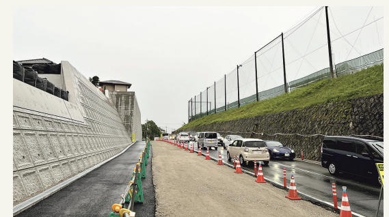
現在は東面の拡幅工事が進行中
