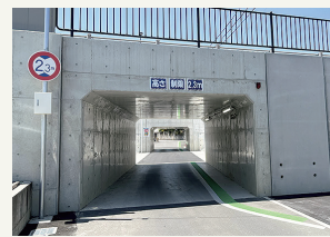
幹線道周辺の通行安全対策
