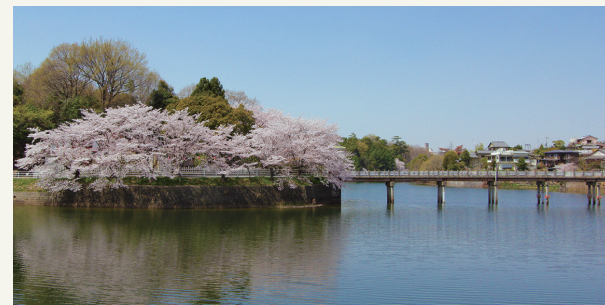
あやめ新橋は、あやめ池小学校へつながる 通学路であり生活道路
