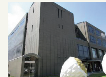
奈良市中央図書館は7/30から8/31まで空調不具合により休館となった
